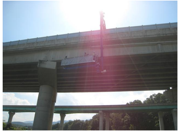
교량점검차를 이용한 근접조사
