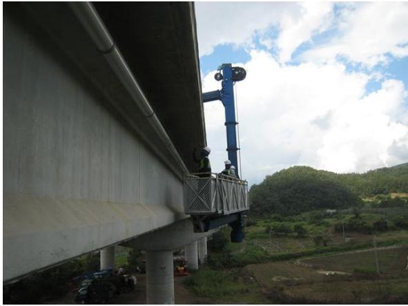
교량점검차를 이용한 근접조사
